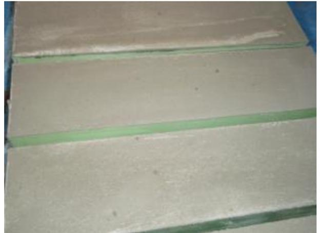
写真 5.2.6 下地調整塗材 C-1 塗布状況
