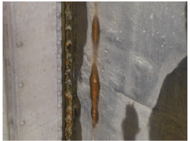
(b) 扉体部における塗装劣化部の腐食
