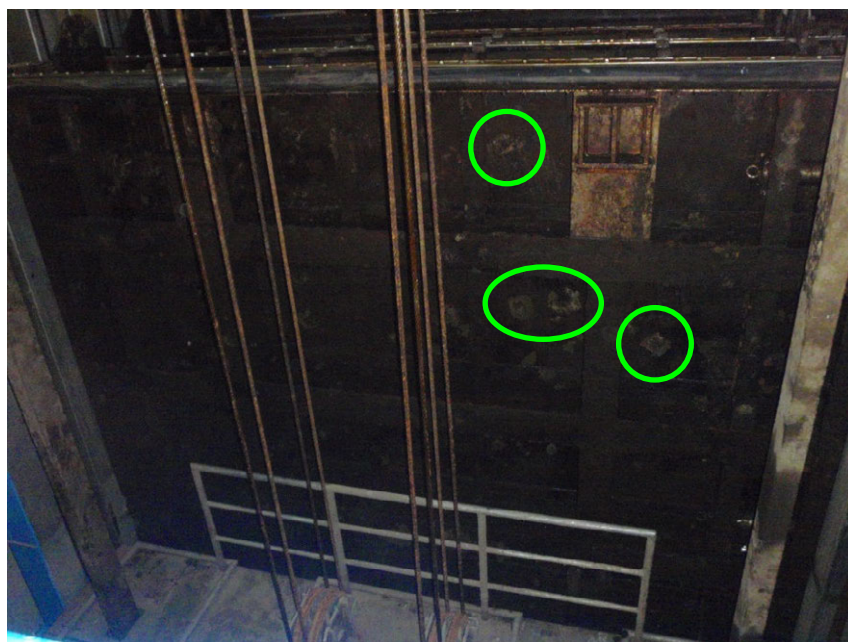
(a) 堰ゲートにおける腐食
