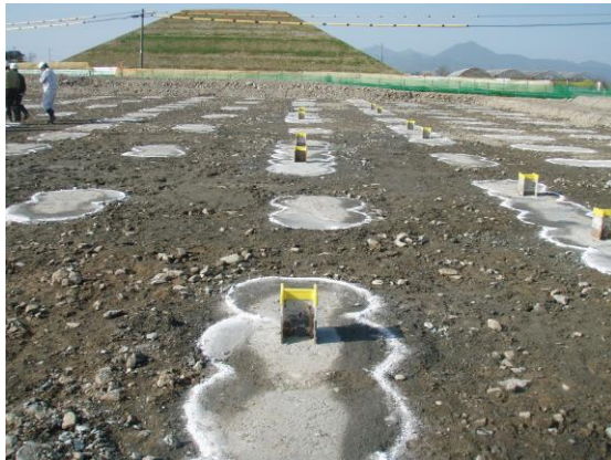
写真 3- 1 改良杭(2 軸)の打設完了(左：縦断方向， 右：横断方向)
