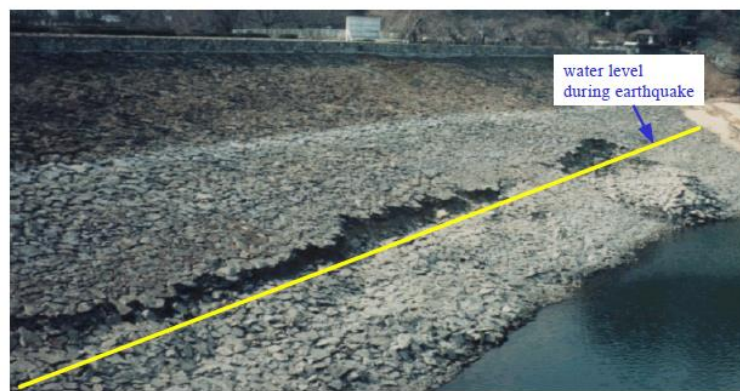
図 2- 15 アースダム堤体の被災状況
