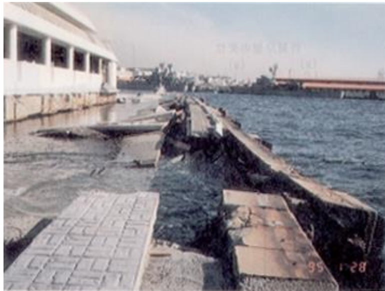
図 1-9 液状化によって崩壊したホテル横の護岸
