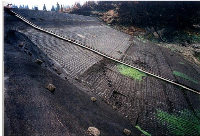
図 2-28 川西ダム上流左岸側でのブロックの変状
