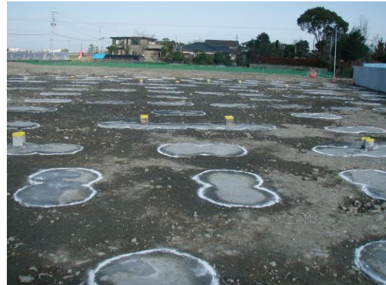
写真 3- 1 改良杭(2 軸)の打設完了(左：縦断方向， 右：横断方向)
