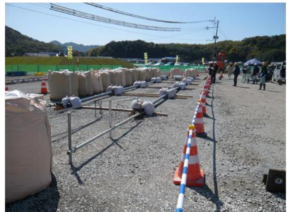
写真 3- 2 敷網材敷設完了(左)， 繋ぎ材の緊結状況(右) (新川他 2010)
