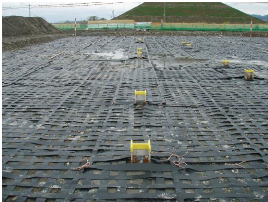
写真 3- 2 敷網材敷設完了(左)， 繋ぎ材の緊結状況(右) (新川他 2010)
