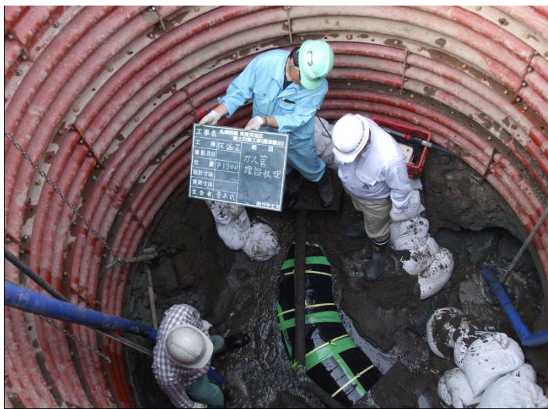
図 4-5 既設高圧ガス導管の試掘状況
