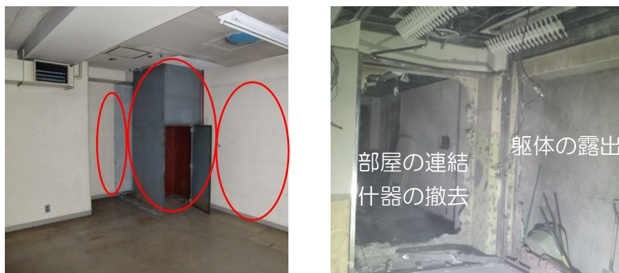
写真 3-1 既存建物の解体前（左）と部分解体後（右）
