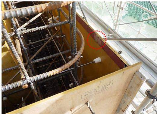
写真-6.1 シート状センサ設置状況
