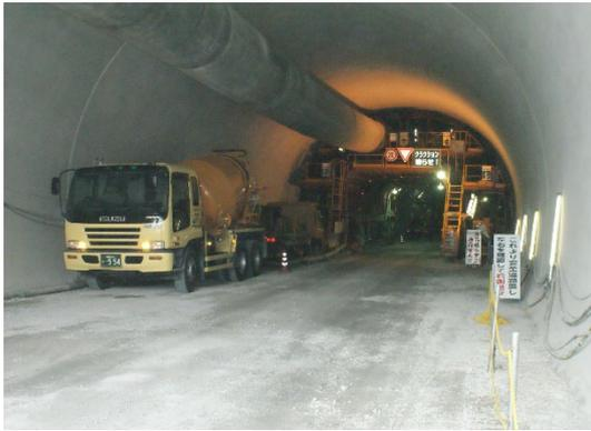
写真-1.5 覆工コンクリート施工状況
