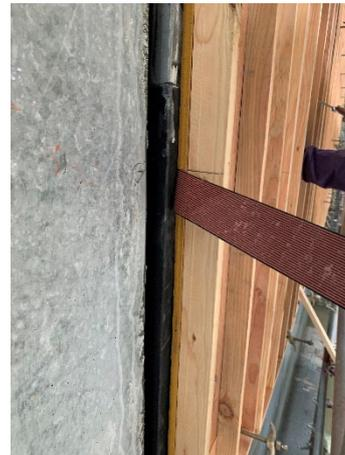
写真-7.7 シート状センサの取出し方法
