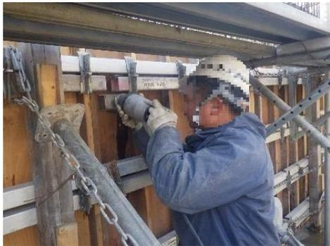
写真-1.3 型枠バイブレータの使用
