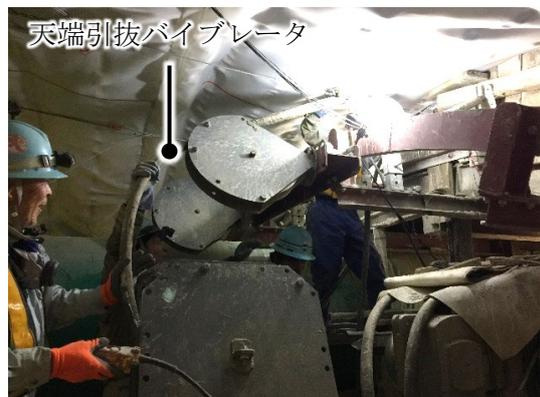
写真-1.10 天端引抜バイブレータ
