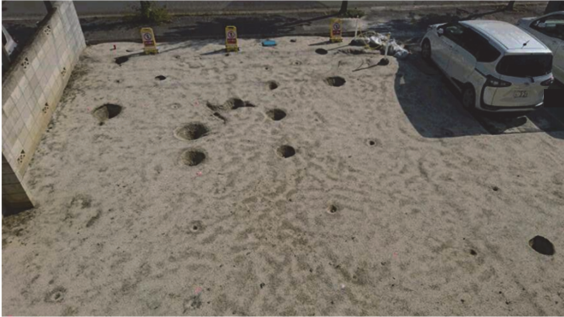
図-2.4 沈下の発生事例
