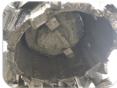
図-5.3 チャッキングにより既存杭を抱えた状態
