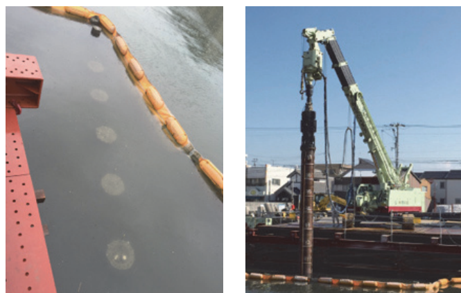
図-5.9 水中に杭頭がある際の PG 工法による引抜き施工例
