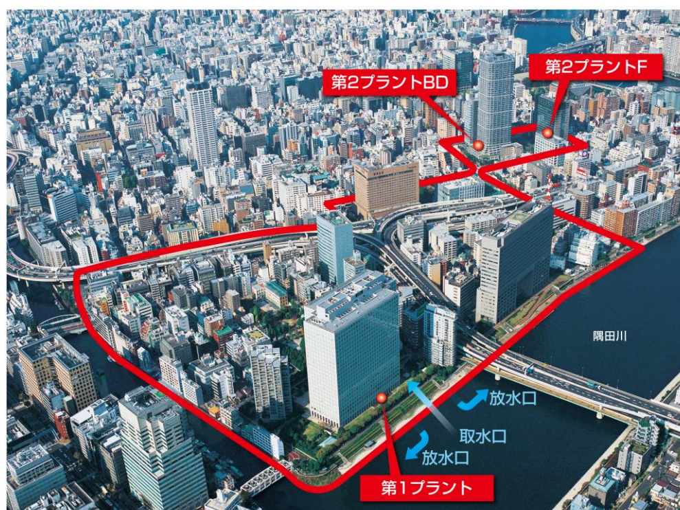
図 4.2.1 箱崎地区熱供給センター 熱供給エリアの全景写真
