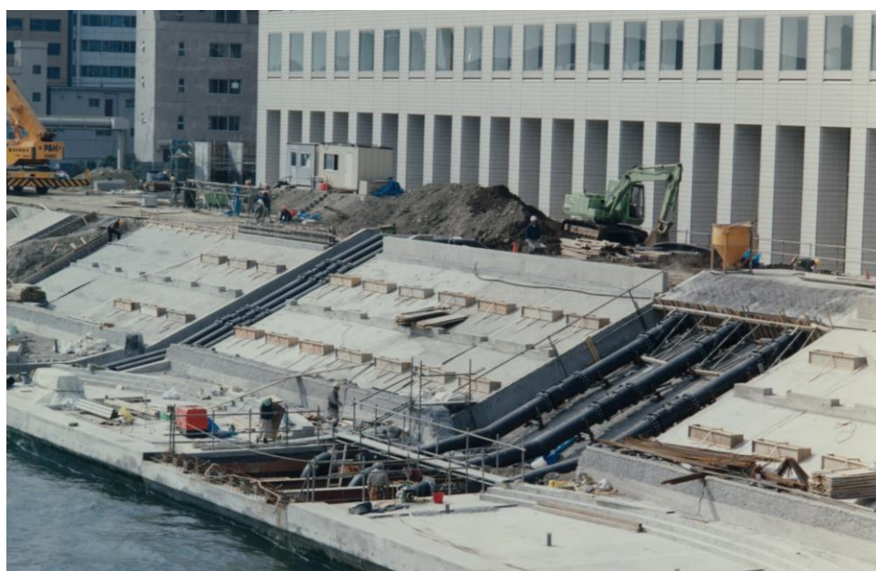
図 4.2.5 河川水の取水設備設置工事中の写真
