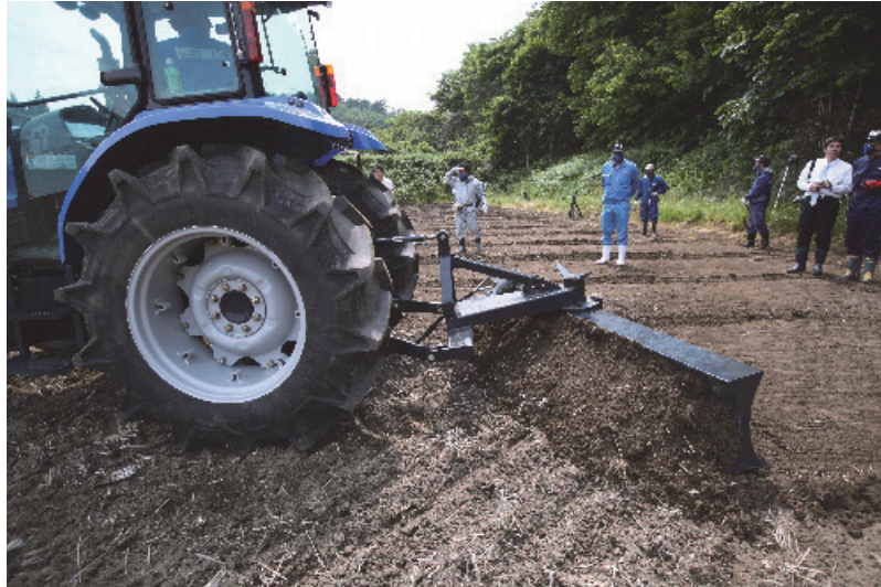
図-2.4 掘削除去の様子
