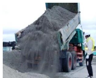
写真 3-5-2 石炭灰改良材の運搬
