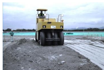
写真 3-5-3 石炭灰改良材の転圧
