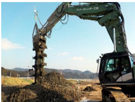
写真 3-4-1 施工状況 (パワーブレンダー工法)
