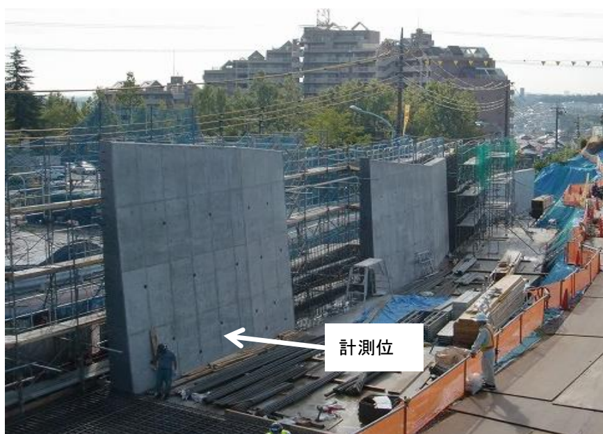
写真-6.1 逆T型擁壁の外観
