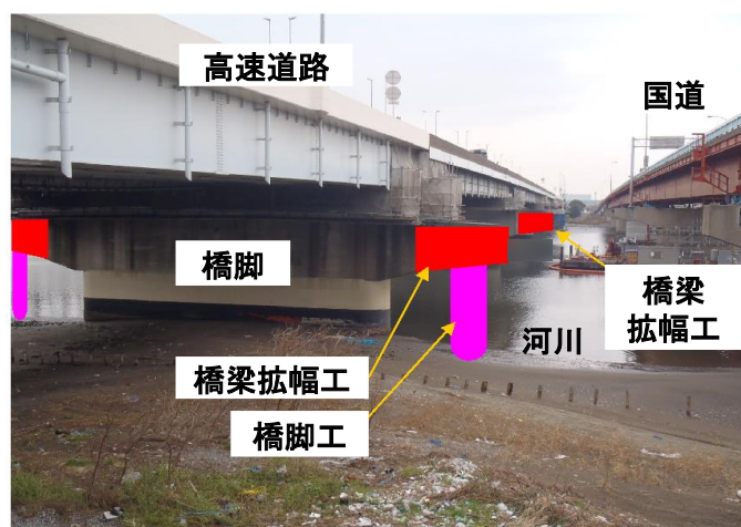
写真-1.1 橋横梁拡幅部
