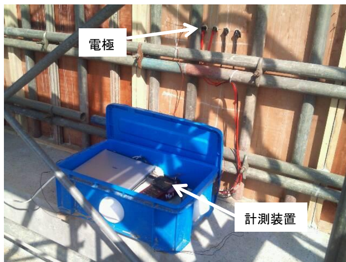
写真-6.2 電気抵抗の計測状況
