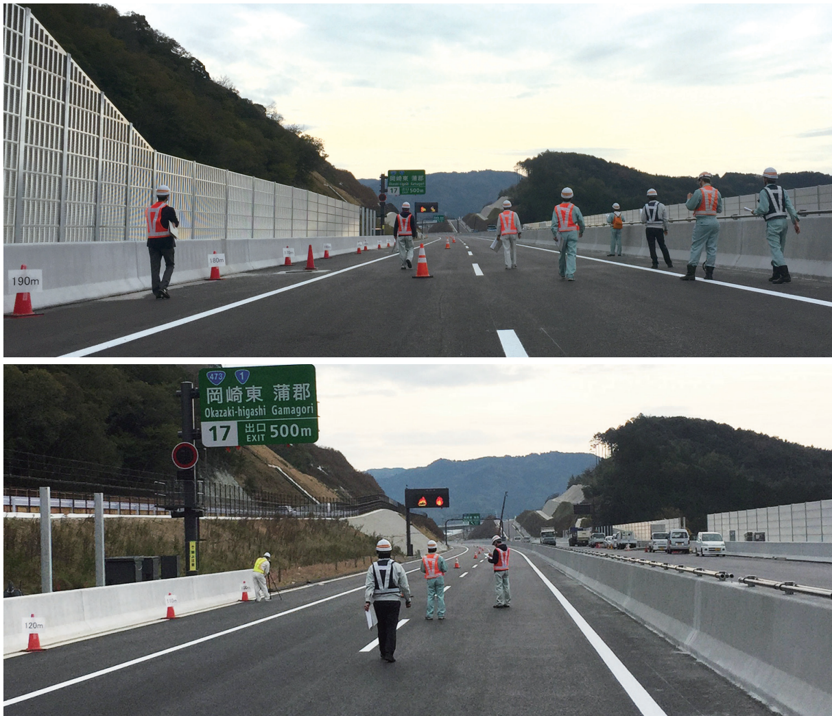
図4-4 実験1：視認距離の測定風景
