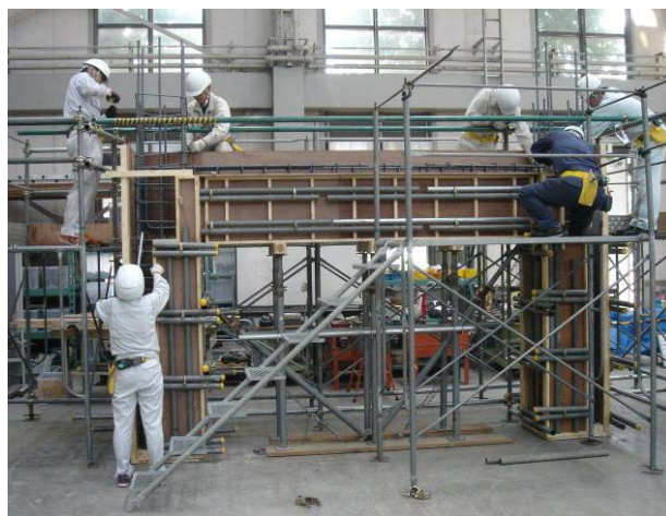
写真 13 RC 造柱・梁モデルの施工実習
