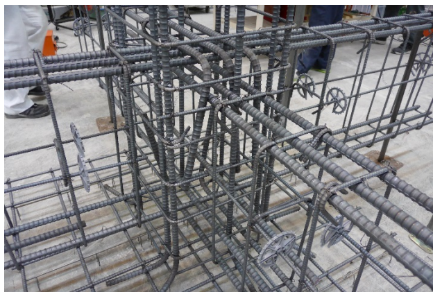
写真 9 組立が完了した鉄筋モデル
