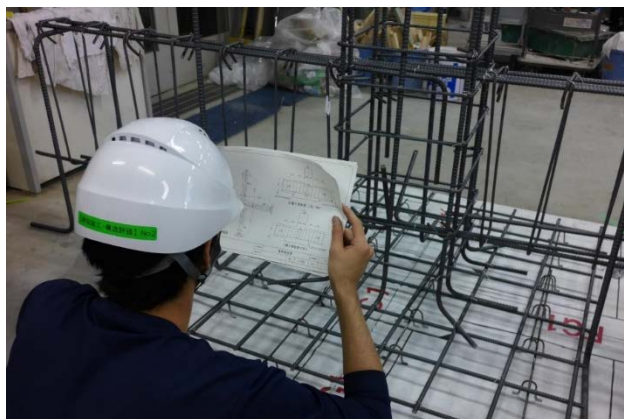
写真 10 2 次元図面のみによる鉄筋組立施工
